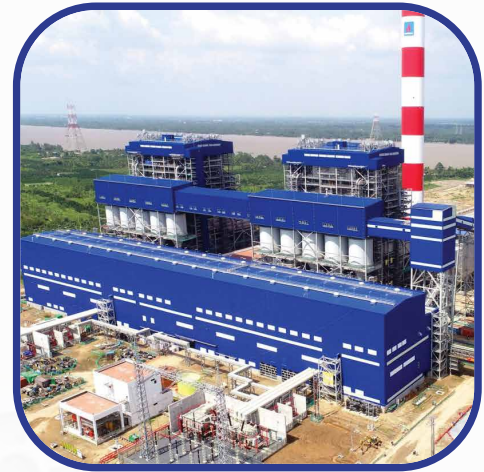
Nhà máy Nhiệt điện Hậu Giang
